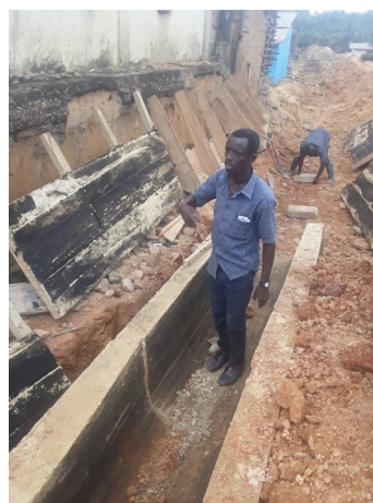
Abitanti di Adjumako al lavoro per fornire il villaggio di una rete fognaria
